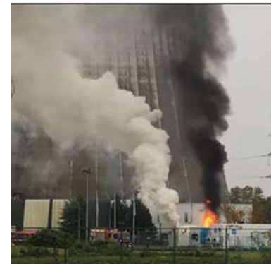
Incendie container batterie Drogenbos (B)
